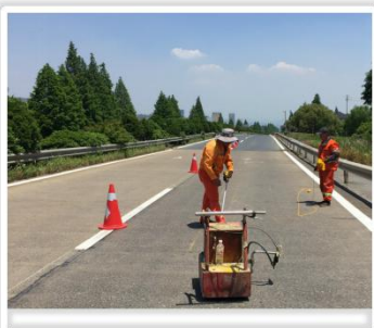
热熔标线施工现场
