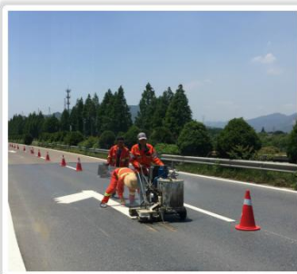
热熔标线施工现场
