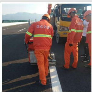
高速公路热熔标线试验路段施工
