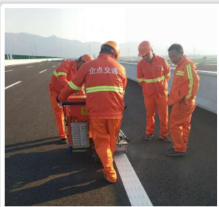
高速公路热熔标线试验路段施工
