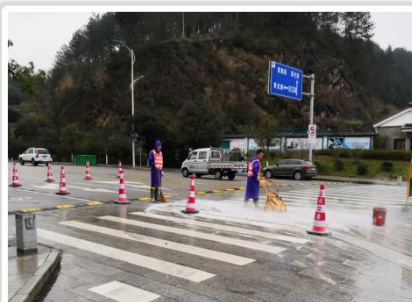
高压水除线施工
